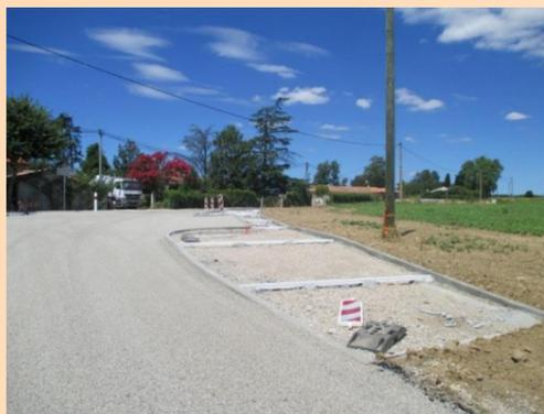
Le département a du acquérir une parcelle de terre afin d'aménager le virage de façon à avoir une meilleure visibilité pour la sécurité des usagers. Il a réalisé deux aires d'arrêt de bus conformes à la réglementation en vigueur relative aux personnes à mobilité réduite. Un abri bus sera posé prochainement. Coût des travaux à charge du département : 50 000 euros.
